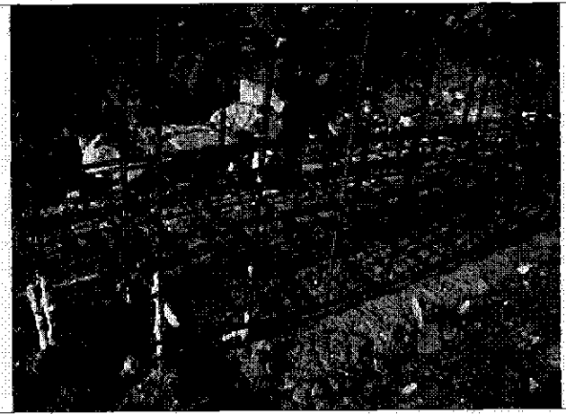
Fotografía N° 4: Fierros que no siguen hacia arriba, correspondiente a pieza "a5" de la armadura.
