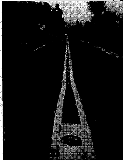
Fotografía N° 20: Escuela La Palma, cuña de isla central no demarcada.
