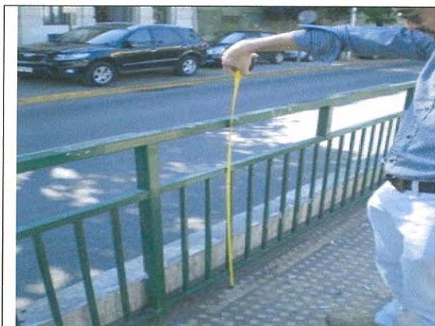
Fotografía N°7: altura de valla peatonal, sector Vicuña Mackenna, entre Irarrázaval y Santa Isabel.
