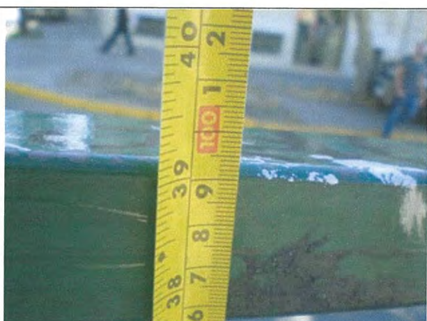
Fotografía N°8: altura de valla peatonal, sector Vicuña Mackenna, entre Irarrázaval y Santa Isabel.
