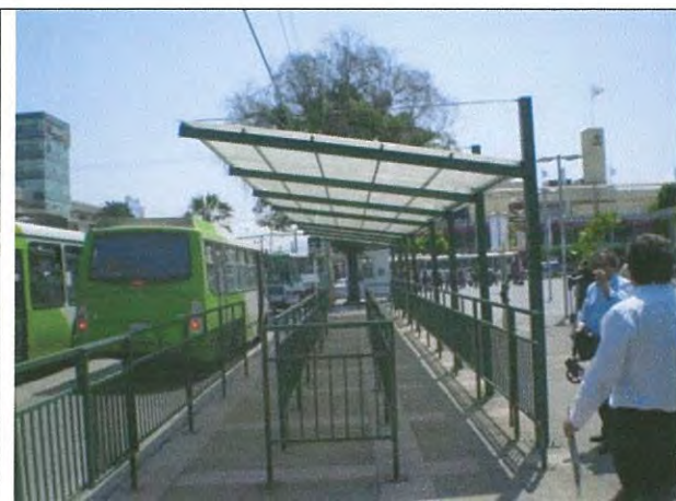
Fotografía N°19: dimensiones cubierta policarbonato, paraderos Plaza Maipú.
