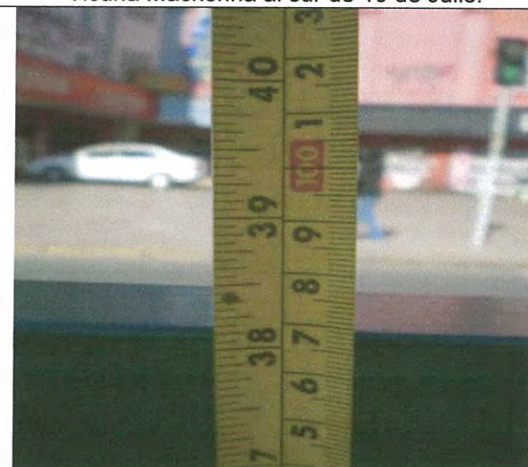
Fotografía N°5: altura de valla peatonal, sector Vicuña Mackenna al sur de 10 de Julio.
