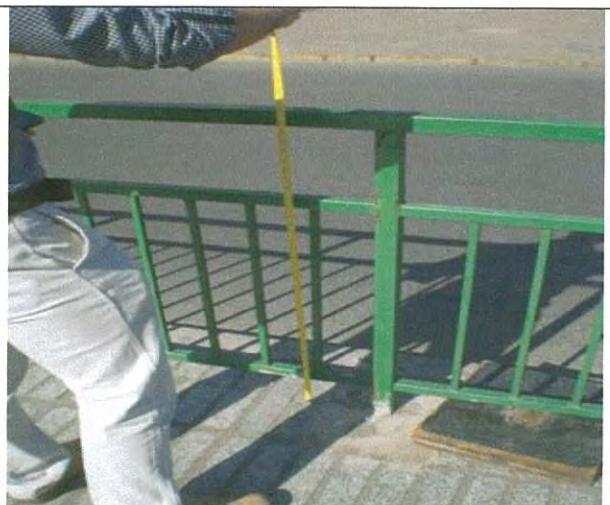
Fotografía N°4: altura de valla peatonal, sector Vicuña Mackenna al sur de 10 de Julio.
