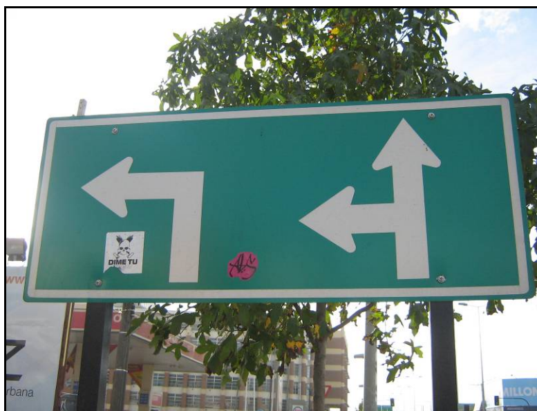
FIGURA 1-2: SEÑALIZACIÓN FUERA DE NORMA EN CONCEPCIÓN
